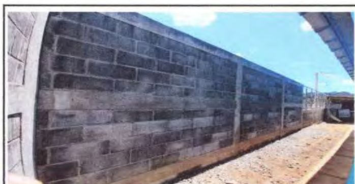
Foto 6: Pintado del muro interior atrás del aula No. 3.
