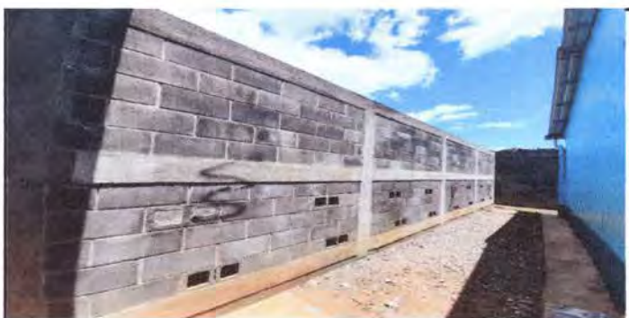
Foto 5: Pintado del muro interior tras del aula No. 3
