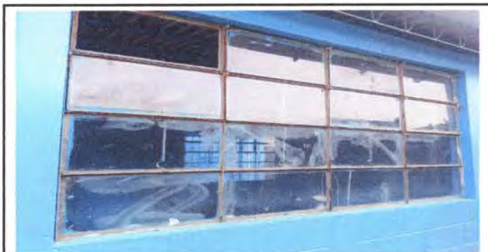
Foto 17: Fabricación e instalación de 2 blaques de hierro en ventana
