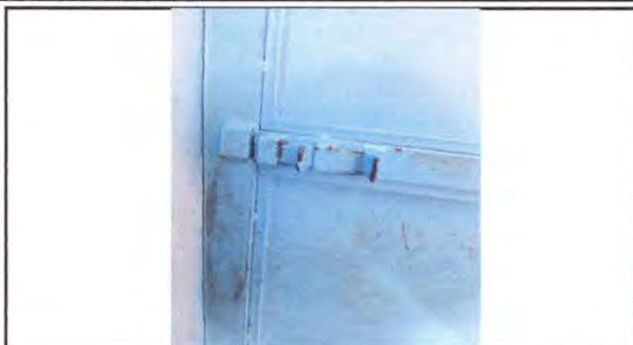
Foto 1: Sustrucción de chapas a puertas
