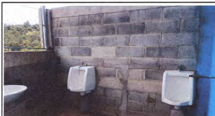
Foto 3: Pintado del muro interior área de mingitorios.
