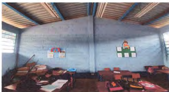
Foto 21: Repello en muro interior más pintura en el aula No. 1
