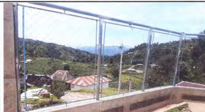
Foto 10: Reparación de tubo hg y malla galvanizada del muro perimetral.
