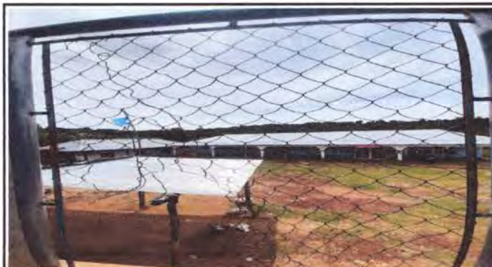
Foto 9: Reparación de tubo hg y malla galvanizada del muro perimetral.
