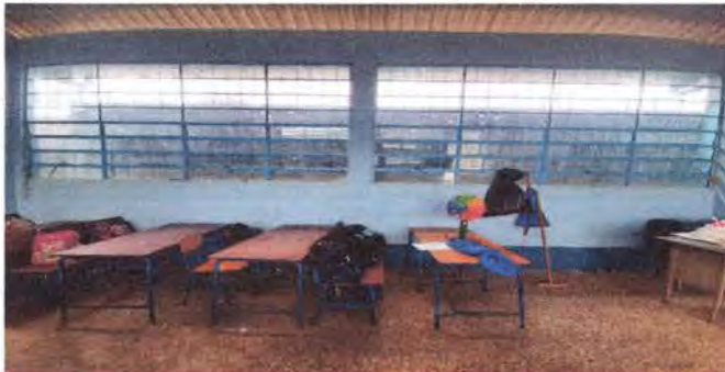
Foto 22: Repello en muro interior más pintura en el aula No. 1
