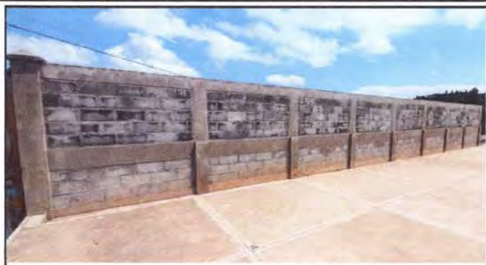
Foto 2: Pintado del muro interior frente de las aulas Nos. 1 y 2.
