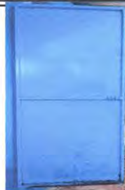
Foto 8: Mantenimiento a puertas de servicios sanitarios
