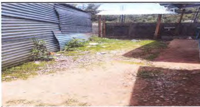
Foto 11: Reparación de plancha de concreto de patio frente los baños.
