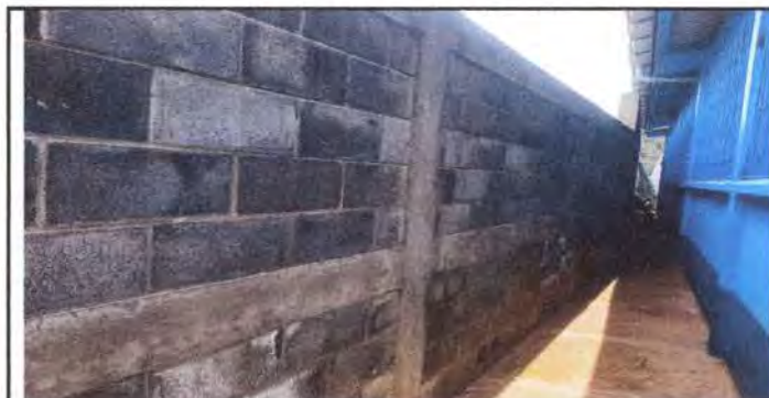
Foto 4: Pintado del muro interior atrás de las aulas No. 1 y 2.
