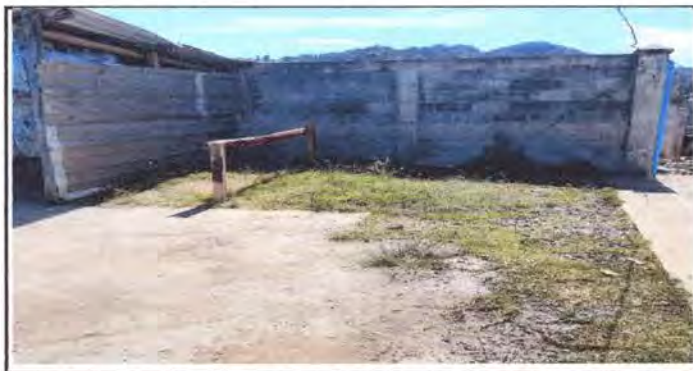
Foto 12: Reparación de plancha de concreto de patio entrada de la escuela.
