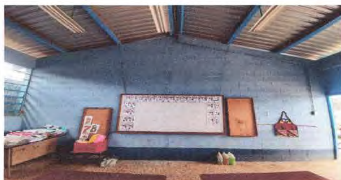
Foto 20: Repello en muro interior más pintura en el aula No. 1
