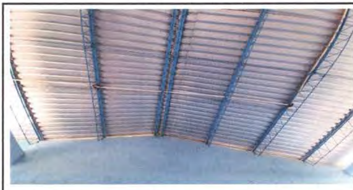
Foto 16: Reparación de cableado eléctrico
